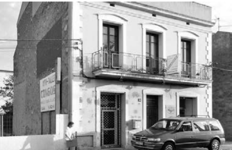
L'edifici abans de la reforma de l'arquitecte Pau Sarquella el 2014
